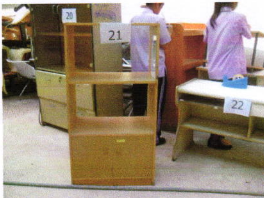
หมายเลข 21 ชั้นวางของ ไม้อัดด้านหลังหลุด เปื่อย เสื่อมสภาพตามอายุการใช้งาน
